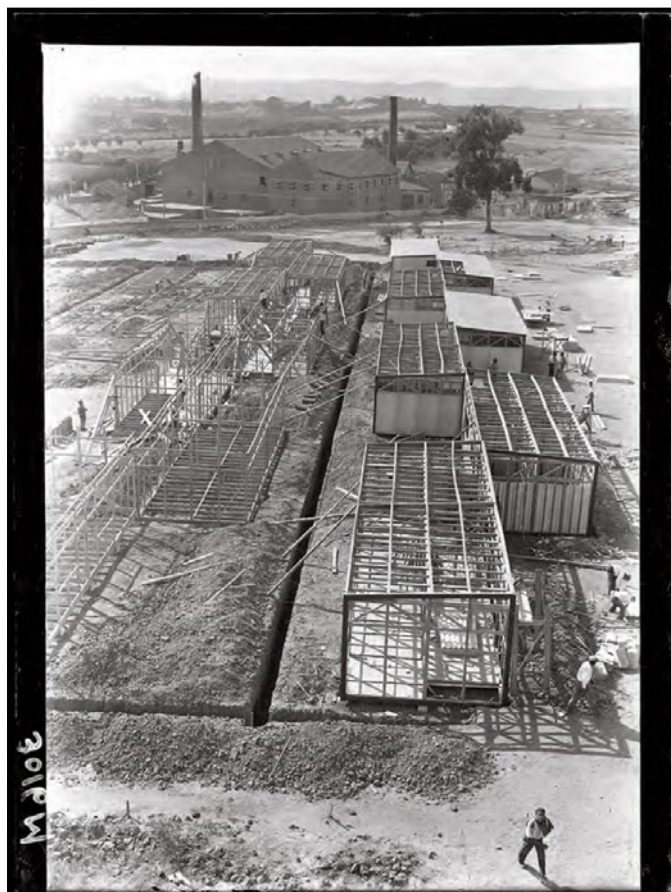
CML (fotografia, 1938-1939). "a) Casas Desmontáveis—Aspecto da Construção das Casas Económicas da [Quinta da] Calçada, em Telheiras. Lisboa, 17 de agosto de 1938".
